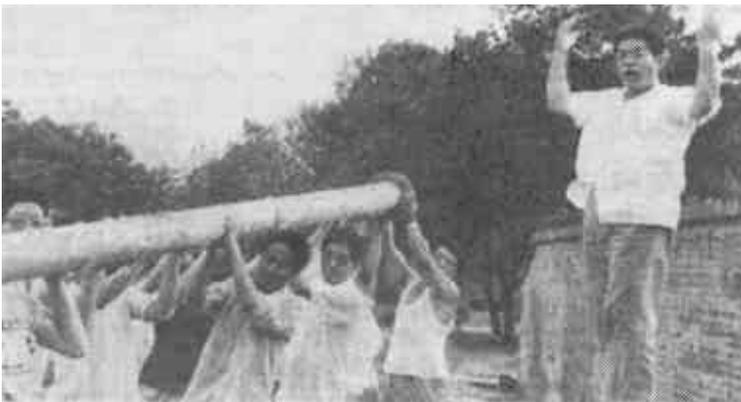
义务劳动蔚成风气。为了节省开支,石油公司坚持自己能干的活决不花钱雇工。几年来,他们先后通过义务劳动,自己动手铺设输油管线450米,装卸润滑油3000余吨,还自己动手焊制粘油罐,安装消防设备,节约资金约10万元。图为干部职工在安装输油管线。
